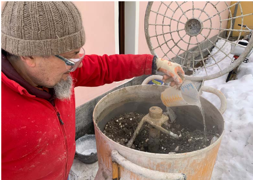
↑ So entsteht Heissmörtel: Ian Gordon-Lennox mischt den Putz und löscht den Kalk.
