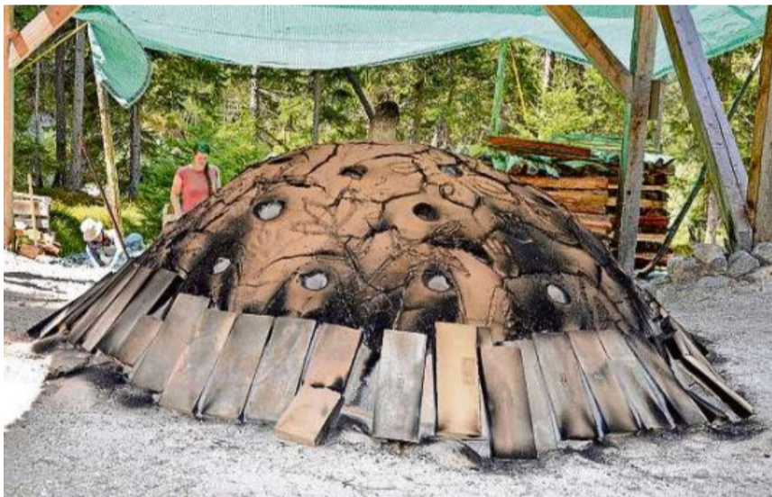
Wie ein Kunstwerk: Der restaurierte Kalkofen «Chalchera Stella» ist mit einem Lehmdeckel abgedichtet worden.
